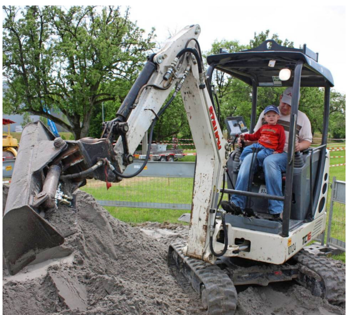
Jung und Alt erleben in Kupferzell unter anderem, wie spannend die Arbeit auf einer Baustelle sein kann.
